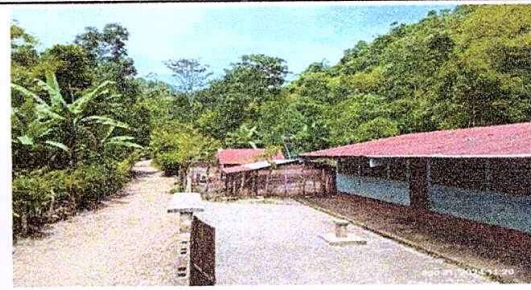
Foto 8: Ampliacion de losa de patio de concreto
