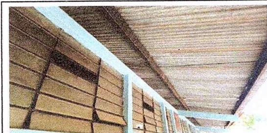
Foto 11: mantenimiento costaneras, lijado y pintado
